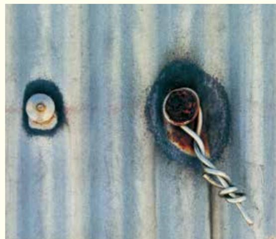
亜鉛めっき笠釘は、腐食が著しく、もらい錆と電食作用で円形状に白錆を呈している
