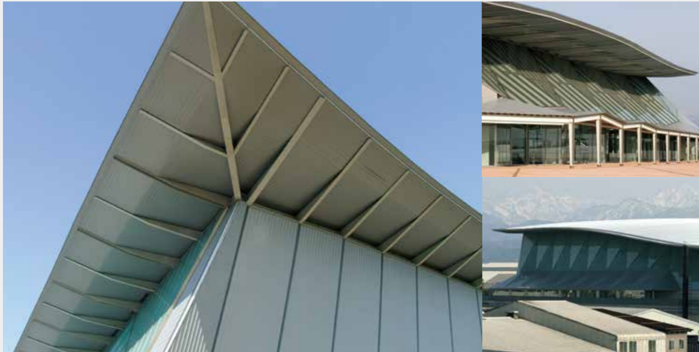
いしかわ総合スポーツセンター / 石川
