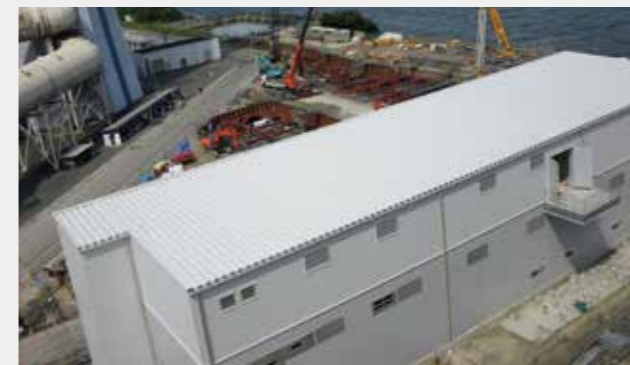
火力発電所 / 千葉県
