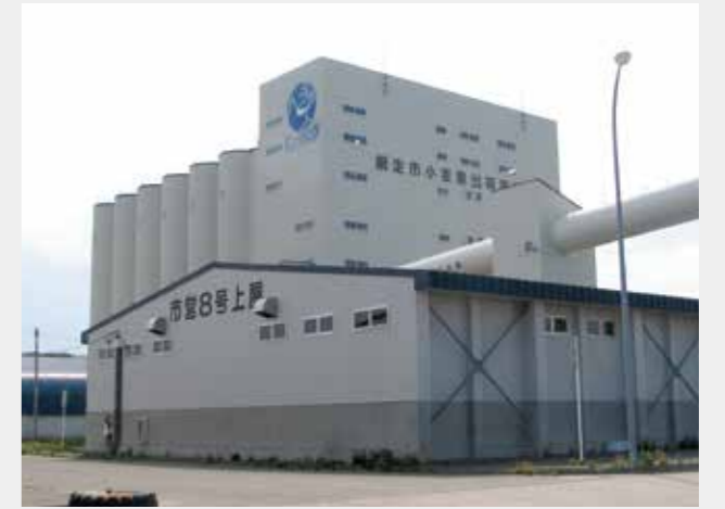
網走港 集出荷施設 / 北海道
