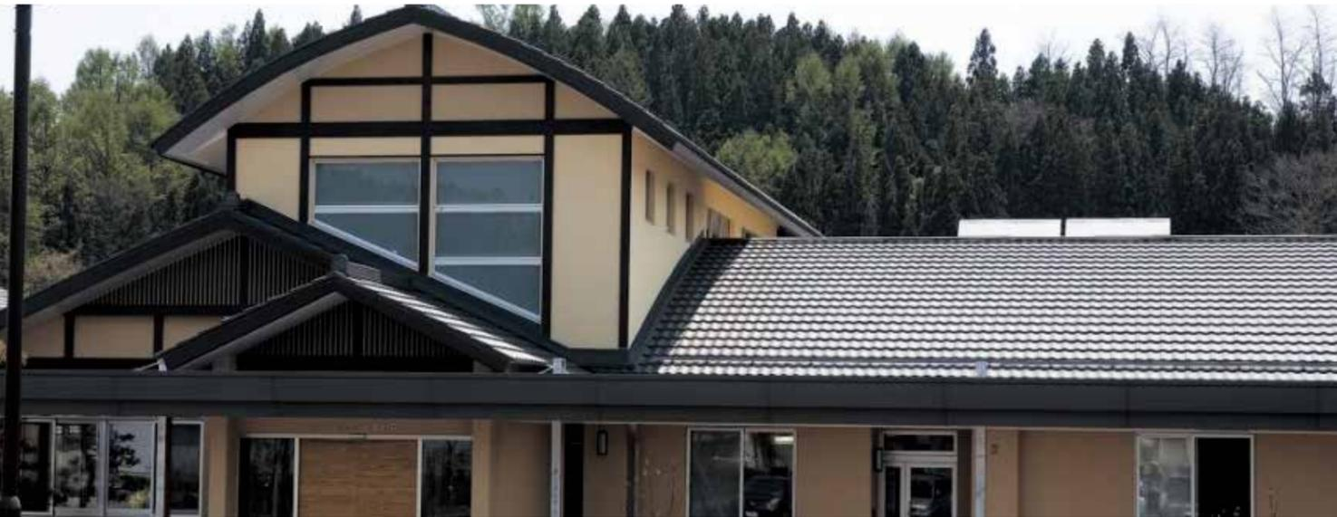
プレス加工技術による現代的な感覚に、日本瓦の品格を持つメタリルは、葺き上がりにしっとりとした趣を醸し出します。一般住宅から店舗や神社仏閣など、新築・改修を問わずさまざまなステージにおいてご好評をいただいております。施工は瓦棧を用い、縦方向、横方向に釘止めする工法です。
