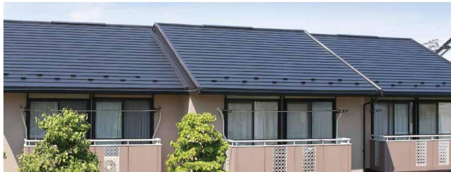
フラットなデザインの中にV型ウェーブが格調の高い意匠を創り出しています。また、ワンタッチジョイントなので継ぎ目が目立ちにくく、ジョイント役物が不要です。屋根材と一体型の断熱材により、断熱性の向上や遮音性がアップし、雨音などを軽減します。
